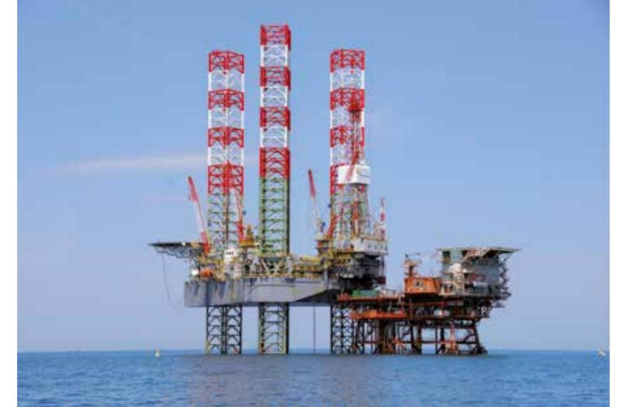
Una piattaforma simile al Paguro, ma di fattura moderna. Le principali differenze sono il lato del triangolo, che è passato a 80 metri e le gambe a sezione quadrata, che sono lunghe 120 metri. L'eliporto è a fianco del modulo alloggi, mentre sul Paguro si trovava in cima a una delle gambe
