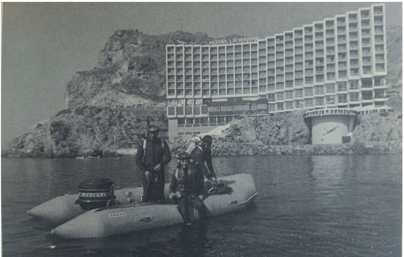
L'Hotel La Parra, sulle coste spagnole di Cabo de Gata. La scuola d'immersione dell'Hotel dispone di una torre subacquea alta dieci metri (in foto), che rende possibile l'addestramento anche col maltempo - Guida del subacqueo: il Mediterraneo, Hans Hass (Milano, 1978)
